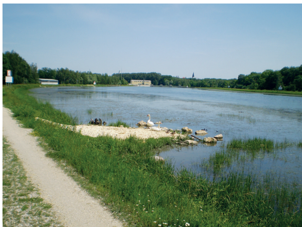
Bild links: Bei der Exkursion zur Donau-Staustufe bei Günzburg erklärte Ralf Klocke von der Bayerischen Elektrizitätswerke GmbH den Teilnehmern den Aufbau der Öko-Bermen.
